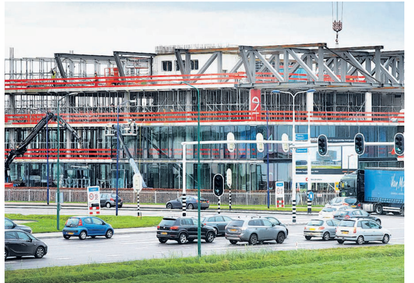
• Bouwwerkzaamheden bij Vanderlande in Veghel. Bedrijven in de regio profiteren volgens het CVO van de investeringsdrift. foto Van Assendelft
